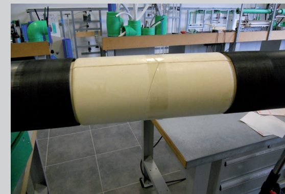
Colocación del aislamiento en la unión
