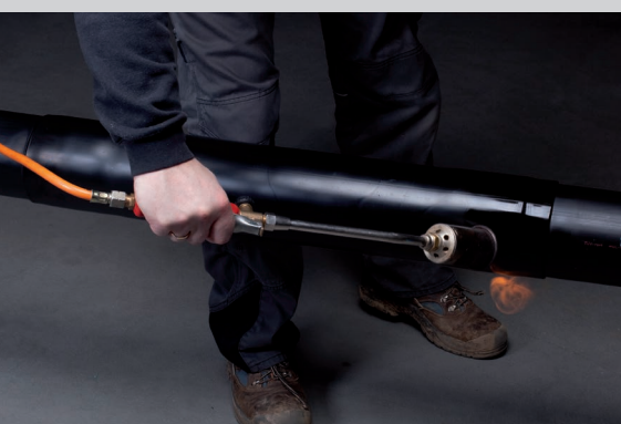
Aplicar calor al manguito termoretráctil
