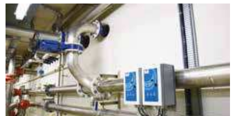
Después de la fermentación, el lodo se transporta a un almacenamiento de tampón de lodo antes del desagüe final.
