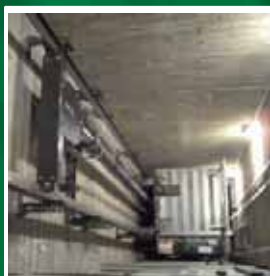
Huecos de ascensor
