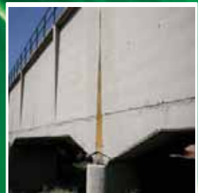
Muros de hormigón
