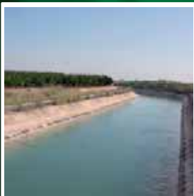
Canales de riego
