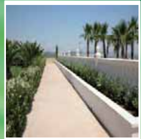
Jardineras de obra
