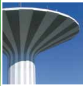
Depósitos de agua
