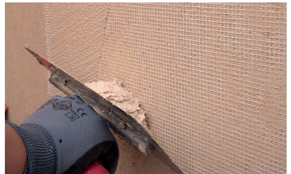
8. Cubrir la malla con PX-28 Isolxtrem SILOXANE TECHNOLOGY F.
