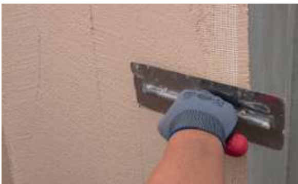
9. Alisar el PX-28 Isolxtrem SILOXANE TECHNOLOGY F depositado sobre la malla.
