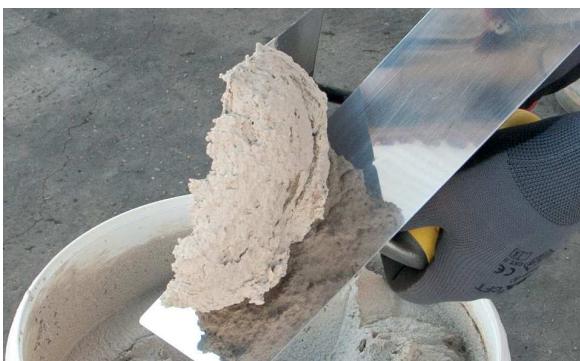
3. Colocar PX-28 Isolxtrem SILOXANE TECHNOLOGY F en la llana.
