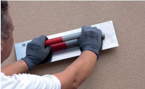
5. Alisar el PX-28 Isolxtrem SILOXANE TECHNOLOGY F.
