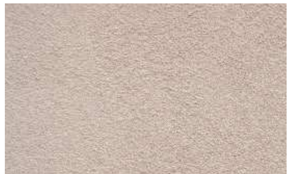
10. Acabado final del PX-28 Isolxtrem SILOXANE TECHNOLOGY F.
