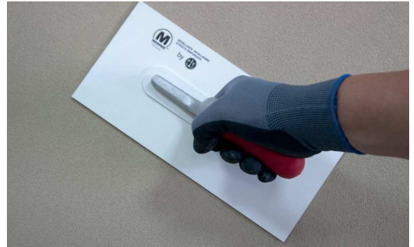
6. Fratar el PX-28 Isolxtrem SILOXANE TECHNOLOGY F.
