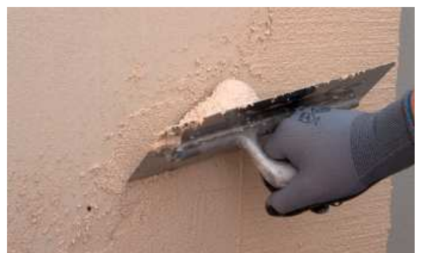
4. Aplicar PX-28 Isolxtrem SILOXANE TECHNOLOGY F sobre el soporte.
