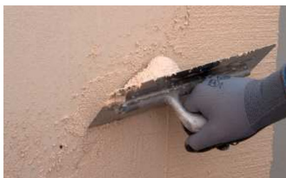
4. Aplicar PX-28 Isolxtrem SILOXANE TECHNOLOGY G sobre el soporte.
