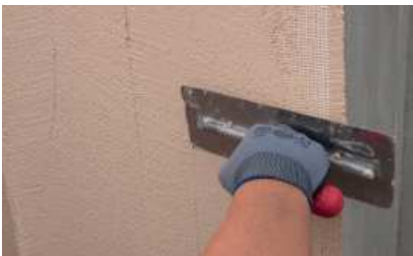
9. Alisar el PX-28 Isolxtrem SILOXANE TECHNOLOGY G depositado sobre la malla.
