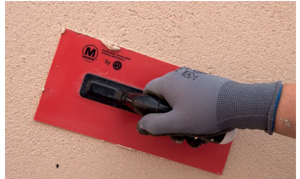
6. Fratar el PX-28 Isolxtrem SILOXANE TECHNOLOGY G.
