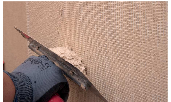
8. Cubrir la malla con PX-28 Isolxtrem SILOXANE TECHNOLOGY G.
