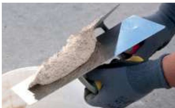
3. Colocar PX-28 Isolxtrem SILOXANE TECHNOLOGY G en la llana.
