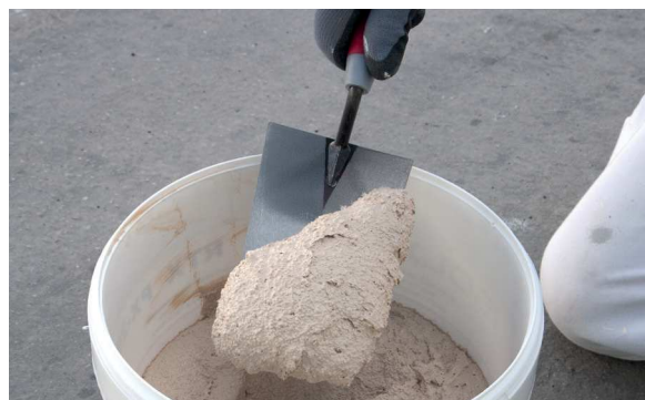
2. Extraer el PX-28 Isolxtrem SILOXANE TECHNOLOGY G con la ayuda de una paleta.
