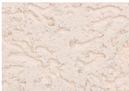
ACRÍLICO RAYADO APLICACIÓN MANUAL Y TERMINACIÓN FRATASADA
