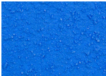
ACRÍLICO / ACRÍLICO SILOX APLICACIÓN PROYECTADA SIN TERMINACIÓN
