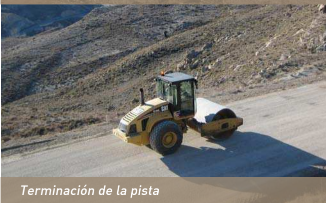
Estado de la pista estabilizada y compactada
