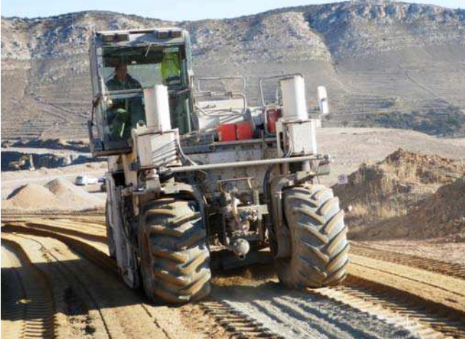
La máquina estabilizadora realiza la mezcla del suelo con el conglomerante
