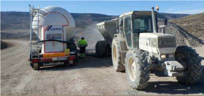
Carga del cemento en la tolva que lo distribuye y dosifica sobre la traza del camino
