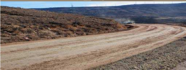
Estado de la pista estabilizada y compactada
