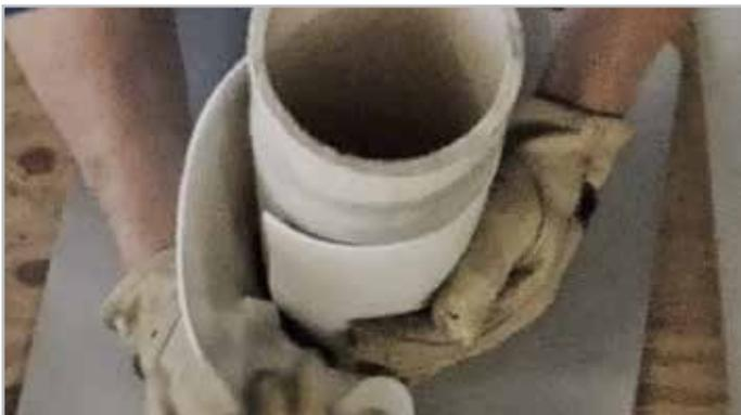
PASO 1. Colocar PF340 alrededor de la penetración
