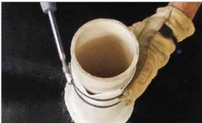
PASO 8. Instale la segunda brida de fijación
