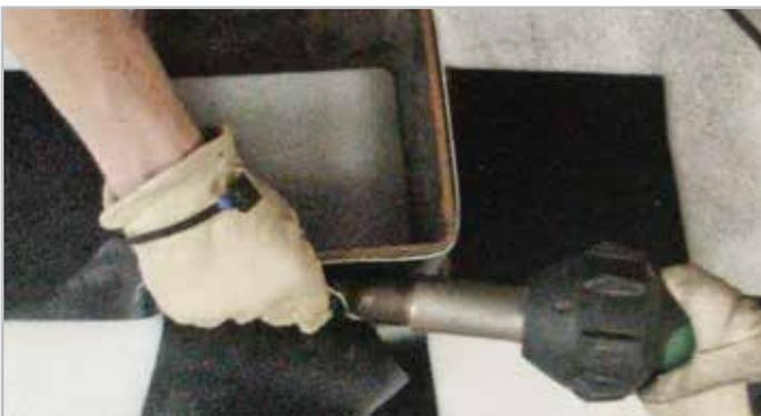
PASO 2. Soldar por puntos el tapajuntas
