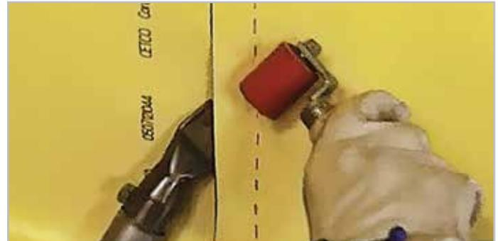
PASO 3. Colocación final de la soldadura
