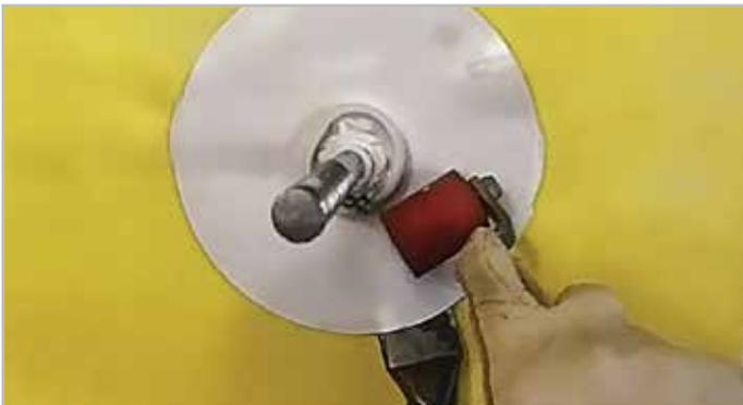
PASO 9. Soldar la brida de PF-150 al COREFLASH
