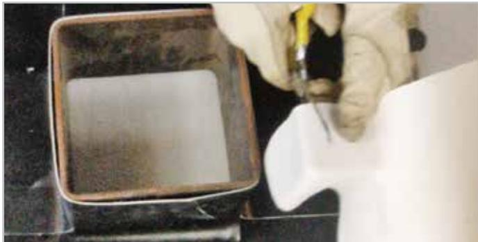
PASO 5A. Cortar las esquinas interiores y exterior para ajustarlas
