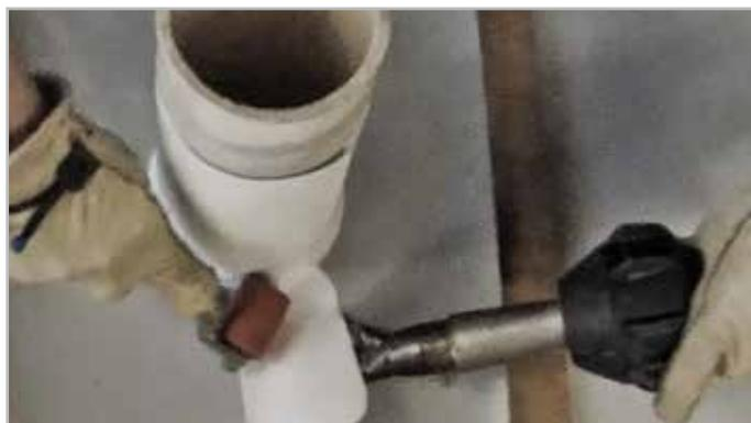
PASO 3. Soldar el solape del PF340 al borde de la brida
