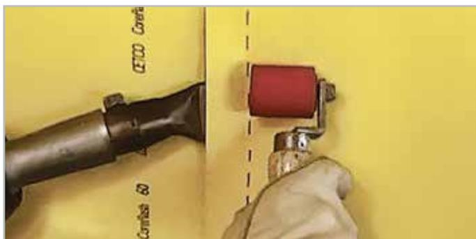
PASO 2. Colocación de la pre-soldadura
