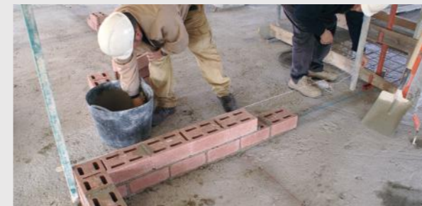
Arranque directo de forjado. Sin bandas.
