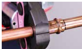
2. Complete la unión con la herramienta. Preense sólo una vez.
