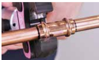
1. Posicione la mordaza perpendicularmente al accesorio
