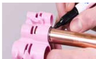
7A. Marque la profundidad de inserción utilizando el medidor de profundidad
