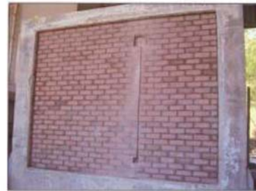
Fotografía 4 Roza realizada en la pared
