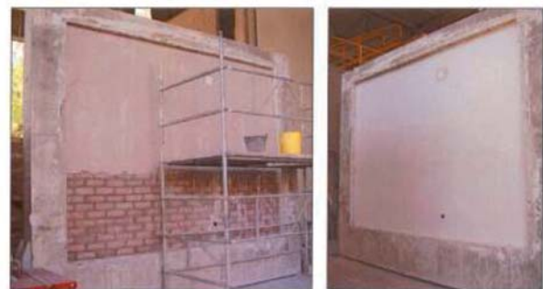
Fotografías 5 y 6 Enyesado de la partición construida en el marco portamuestras
