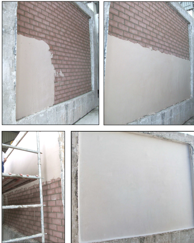
Imágenes 10, 11, 12 y 13 Enyesado del cerramiento construido
