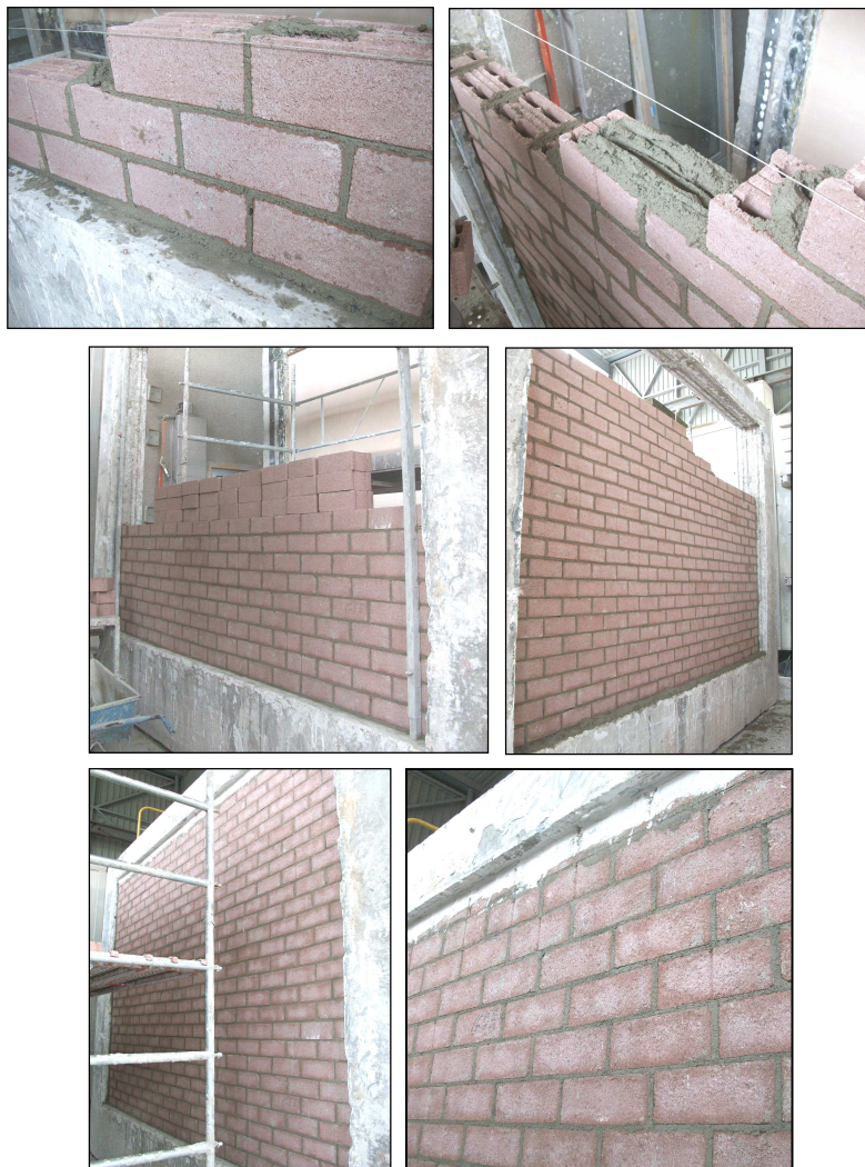
Imágenes 4, 5, 6, 7, 8 y 9 Construcción de la pared de GEROBLOCK CÁMARA ACÚSTICO 55 dBA
