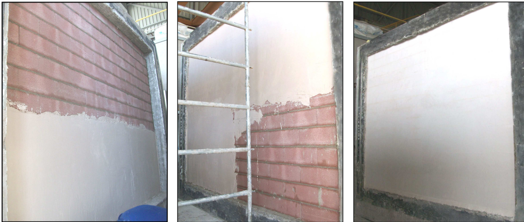
Imágenes 9, 10 y 11 Enyesado del cerramiento construido
