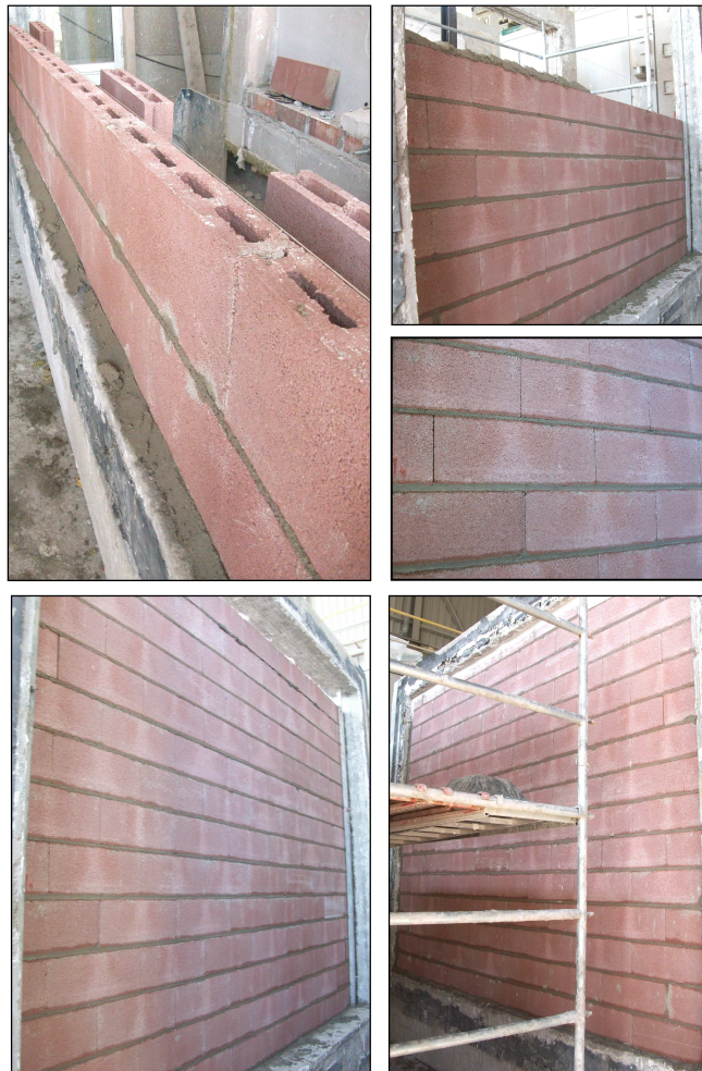
Imágenes 4, 5, 6, 7 y 8 Construcción de la pared de GEROBLOCK TABIQUE ACÚSTICO 38 dBA
