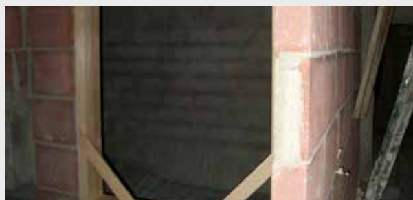
Arranque directo de forjado (sin bandas).
