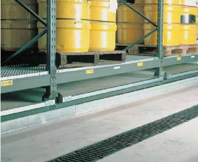
Para la unión con la tubería general de evacuación se dispone también de un canal provisto de válvula de seguridad, que permite, en caso de derrame accidental, retener líquidos contaminantes dentro del canal.
