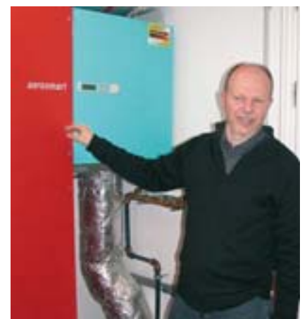
Los Sistemas de Ventilación Confortable con una calefacción y un suministro de agua caliente integrados ya se presentan en forma de unidades compactas que no necesitan más espacio que una nevera convencional. (Ing. Lang Consulting)
