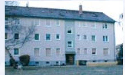
Bloque de viviendas después de la rehabilitación energética.
