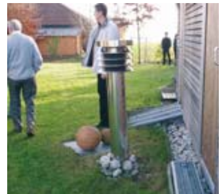
La "nariz" de una vivienda pasiva: conducto de aire para el suministro de aire fresco.
