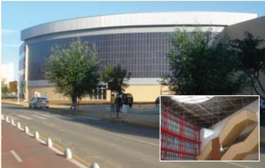
Maxiaulario Universidad de Huelva (Campus de El Carmen, Universidad de Huelva). Arquitectos: LAR Laboratorio de Arquitectura Responsable. Sergio Gómez Melgar (*).
