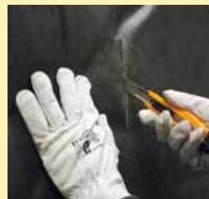
3 Corte del Ecovent para extracción de las ménsulas.
