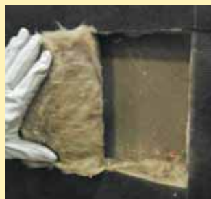
2 Apertura del Ecovent tipo ventana para colocación de la ménsula.
