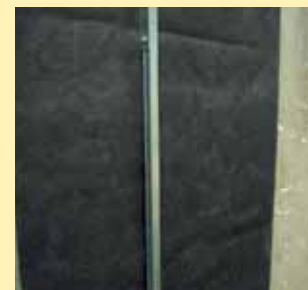
4 Colocación de los montantes verticales de la estructura.
