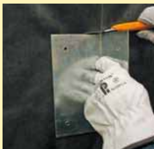
1 Corte del Ecovent ya instalado según el tamaño de la ménsula.
