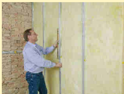
5. Colocar la Lana Mineral ISOVER: ECO D 032.
