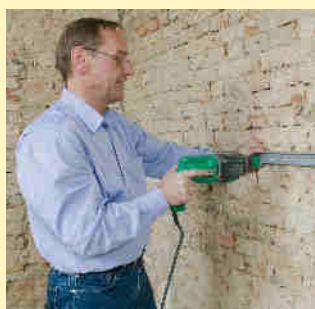
1. Fijación de los perfiles OPTIMA 240.
