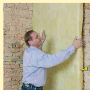
4. Colocar la Lana Mineral ISOVER: ECO D 032 y los Clips OPTIMA 2 .
