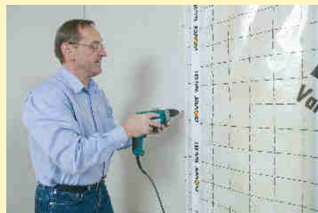
7. Fijación de la Placa de Yeso Laminado.
