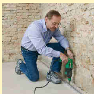
2. Fijación de los perfiles OPTIMA U ST.
