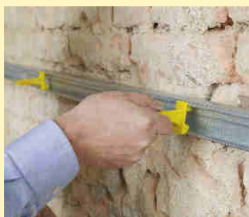
3. Colocar los Clips OPTIMA 2 .
