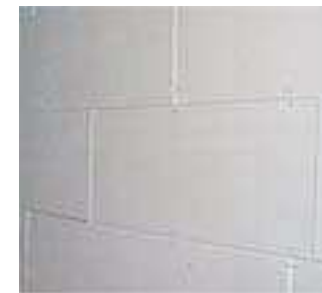
Placas Knauf Safeboard instaladas
