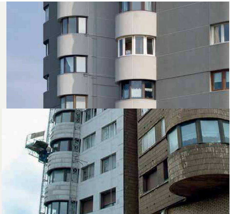
Rehabilitación de fachada Rentería, Gipuzkoa
