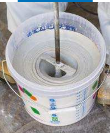
Mezcla de Mape-Antique Ecolastic
