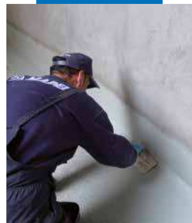
Mapelastic Foundation aplicado con llana, en una intervención de impermeabilización a contrapresión
