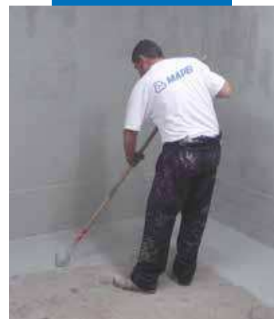
Mapelastic Foundation aplicado a rodillo, en una intervención de impermeabilización a contrapresión
