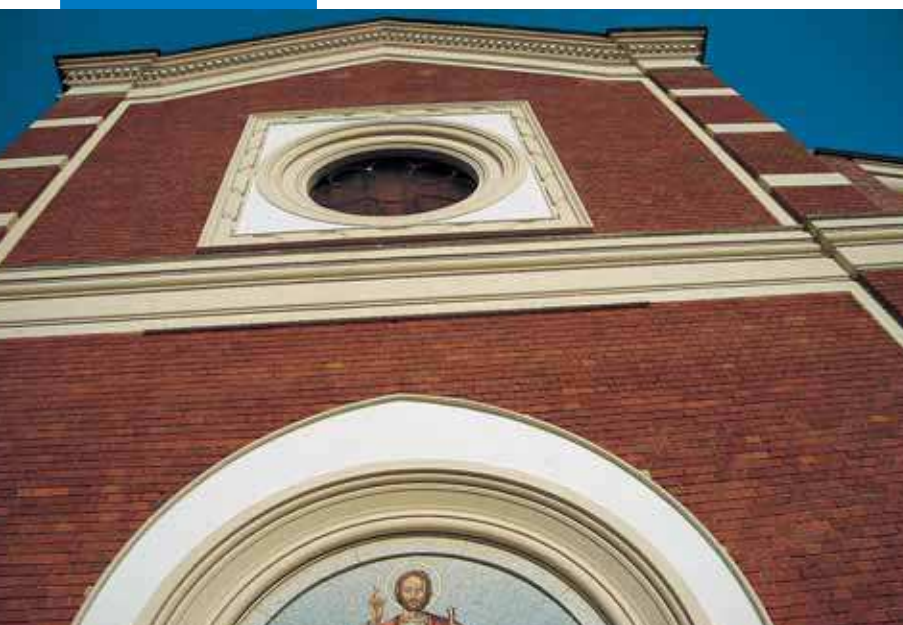
Tratamiento de ladrillos caravista
