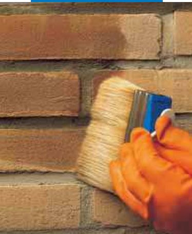
Aplicación a brocha de Antipluviol S
