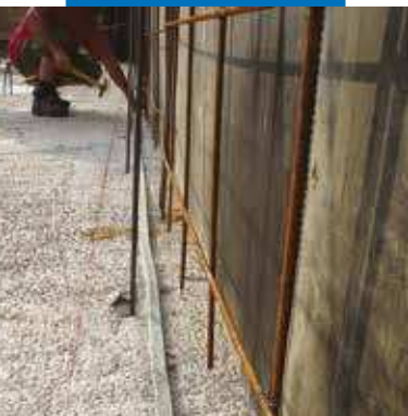
Colocación de Idrostop B25
