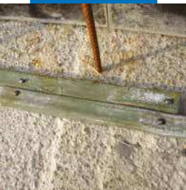
Solape de los extremos de Idrostop B25
