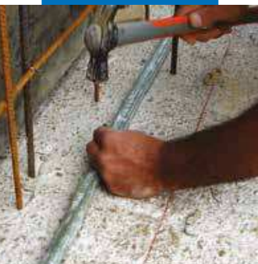
Fijación de Idrostop B25 a la superficie de hormigón
