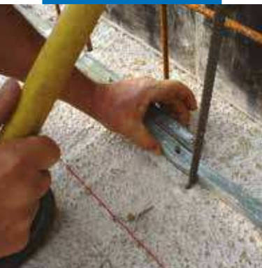
Solape de los extremos de Idrostop B25
