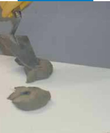
Aplicación de Mapetherm AR1 sobre el reverso del panel, a toques con paleta
