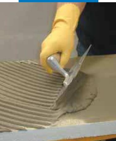
Aplicación de Mapetherm AR1 sobre el reverso del panel, con llana dentada
