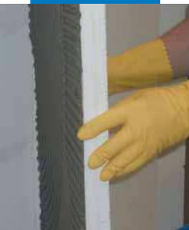
Colocación de paneles termoaislantes
