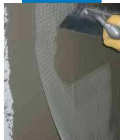
Enlucido de paneles termoaislantes armado con Malla de Fibra de Vidrio embebida en la capa de Mapetherm AR1
