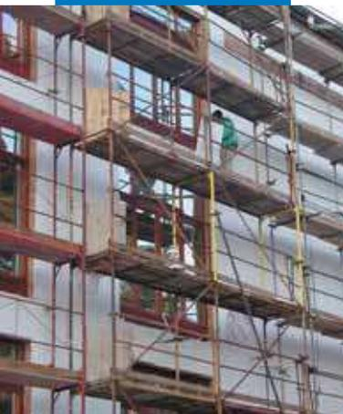
Encolado de las placas aislantes a la fachada con Mapetherm AR1
