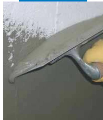
Enlucido de paneles termoaislantes: extensión de Mapetherm AR1
