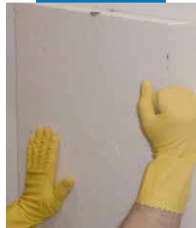
Presionado de los paneles, después de su colocación, para asegurar una buena adhesión al soporte
