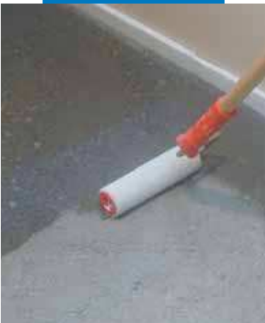
Aplicación de Primer G con rodillo
