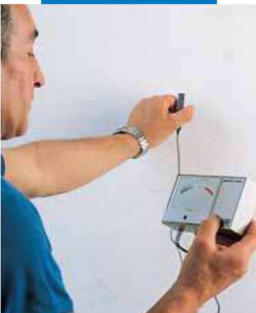
Comprobación de la humedad del yeso
