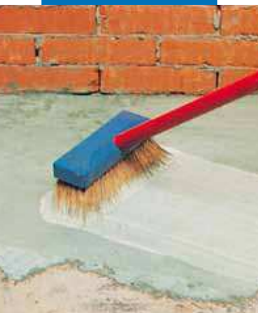
Aplicación de una lechada cementosa aditivada con Planicrete
