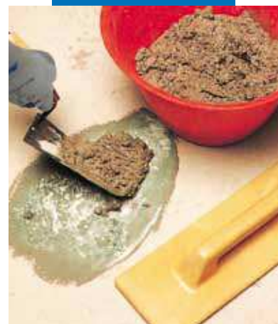
Reparación de un pavimento: aplicación del mortero
