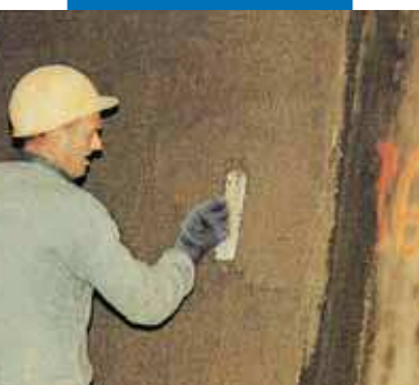
Revoque cementoso con Planicrete. Obra del túnel de la autopista Ville Marie en Montreal - Canadá
