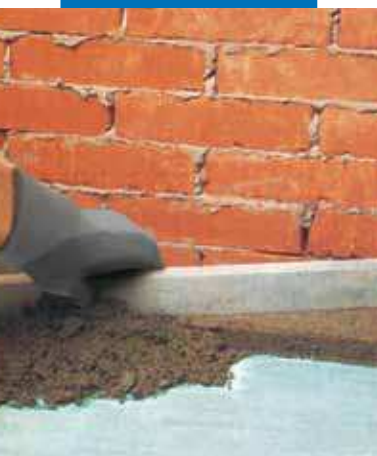
Aplicación de un recrecido cementoso adherente aditivado con Planicrete
