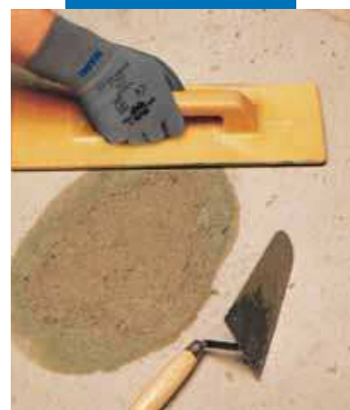
Reparación de un pavimento: fratasado final
