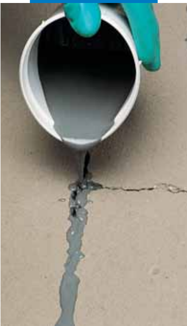
Reparación de grieta en solera cementosa con Eporip
