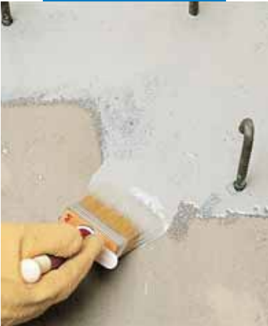
Aplicación de Eporip con brocha para puente de unión
