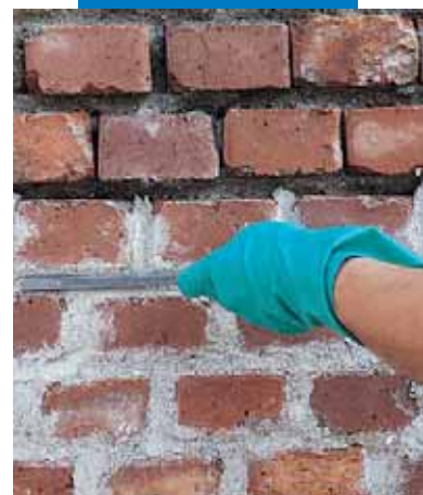
Acabado de las juntas de la fábrica rellenas con Mape-Antique MC
