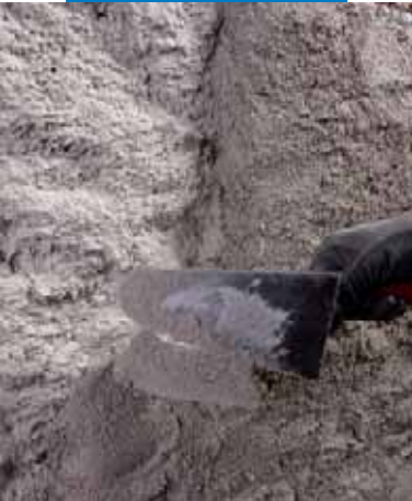
Aplicación de Mape-Antique MC sobre Mape-Antique Rinzafo
