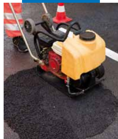
Compactación mecánica de Mape-Asphalt Repair 0/8
