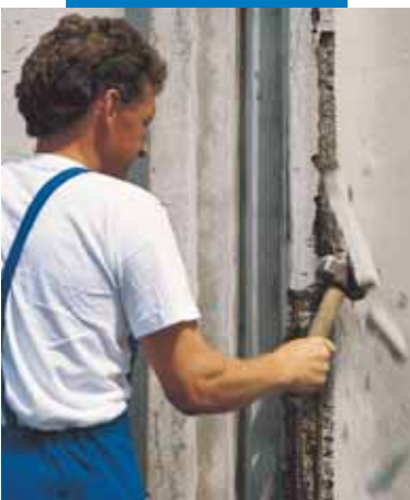
Demolición del hormigón degradado
