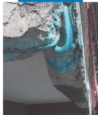
Hierros de armadura del frente de un balcón tratados con Mapefer 1K
