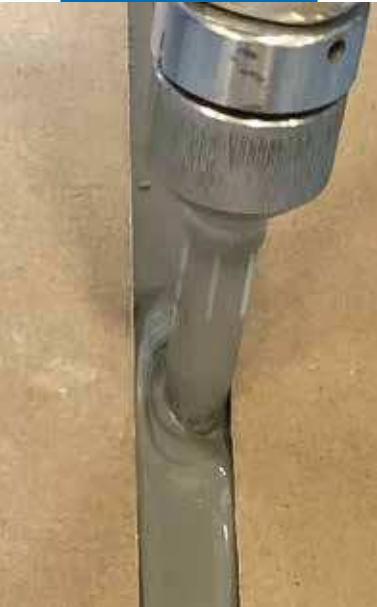
Aplicación con bomba Mapeflex SPP
