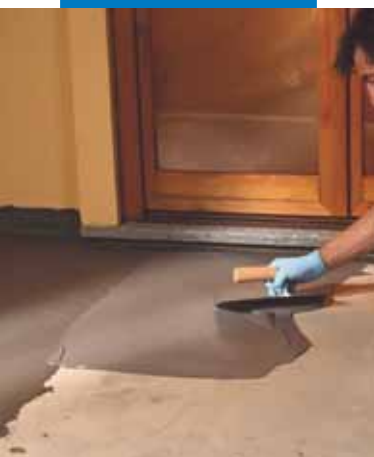
Impermeabilización de arqueta de hormigón a brocha
