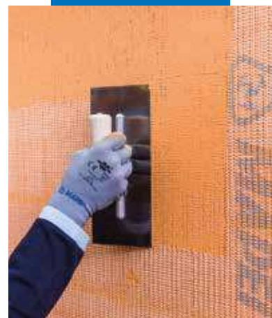
Inserción de Mapetherm Net en la capa fresca de Mapetherm Flex RP
