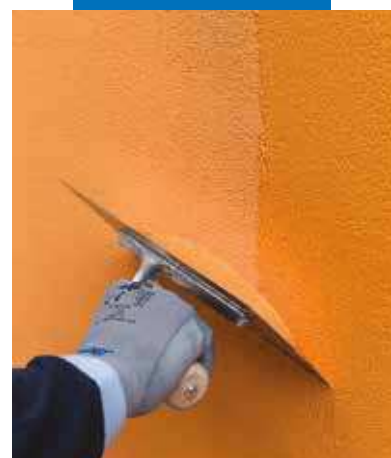
Acabado con aplicación a llana de Elastocolor Tonachino Plus sobre Mapetherm Flex RP 1,5 mm
