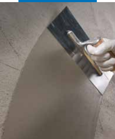
Aplicación de Planitop 200 sobre hormigón
