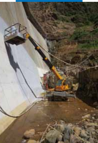
Impermeabilización de una presa
