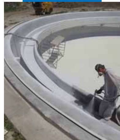
Aplicación de Purtop 1000 en depósitos industriales
