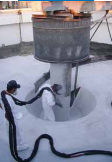
Detalle de impermeabilización con Purtop 1000 sobre soportes diversos (cementosos y metálicos)
