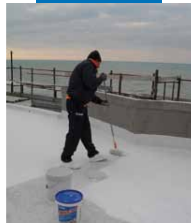
Aplicación a rodillo de Triblock P sobre superficie de hormigón
