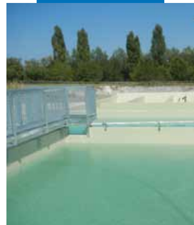
Depósitos impermeabilizados con Purtop 1000
