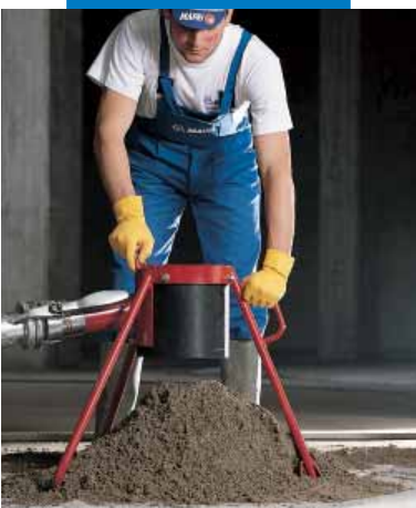
Suministro del mortero Topcem
