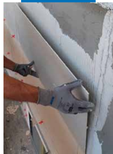
Aplicación de la baldosa de gres porcelánico fino sobre fachada exterior
