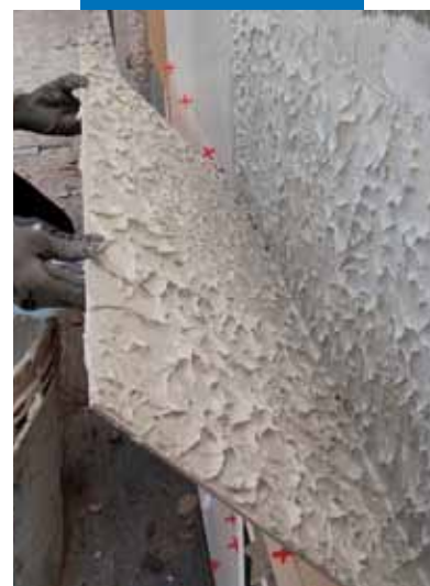
Comprobación de la completa impregnación del reverso de la baldosa en colocación en fachada exterior
