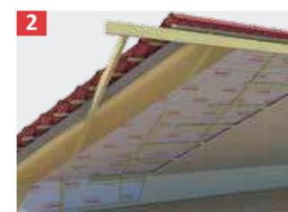
2 Fije la lámina barrera para vapor ONDUTISS® BARRIER al soporte mediante grapas. Evitar cualquier daño de la lámina. Utilice ONDUTISS® UNO para sellar herméticamente todos los solape y uniones. De acuerdo con su sistema de cubierta, colocar ONDUTISS® BARRIER sobre un soporte continuo de la cubierta o colocando rastreles transversales a la estructura para proteger el aérea de fijación.
