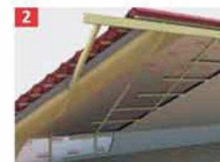
Fijar mecánicamente la lámina barrera de vapor ONDUTISS® BARRIER REFLEX a la cubierta. Evitar cualquier daño de la lámina. Utilice ONDUFILM® o una cinta de doble cara para un sellado hermético de todas las juntas. De acuerdo con el sistema constructivo de la cubierta, fijar ONDUTISS® BARRIER REFLEX en posición mediante la sujeción de los paneles interiores de cubierta o fijando un enrastrelado sobre la membrana protegiendo las líneas de fijación de esta.
