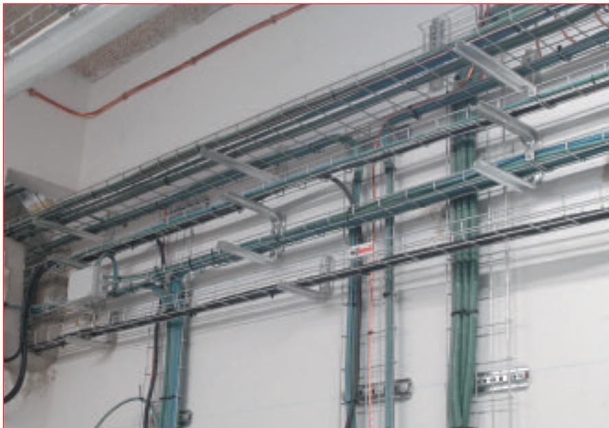
El nuevo Reglamento Electrotécnico para Baja Tensión (REBT 2002) aumentó su nivel de exigencias impidiendo el uso de materiales que pueden incrementar estos riesgos, para que los cables y sistemas de instalación no reduzcan las características de la seguridad contra incendios y, en ciertas instalaciones, exigiendo que los cables sean no propagadores del incendio y con emisión de humos y opacidad reducida, los conocidos como cables libres de halógenos.
