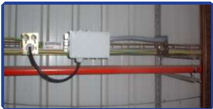
Montaje de prensaestopas, caja y salida de tubos en bandeja Rejiband.
