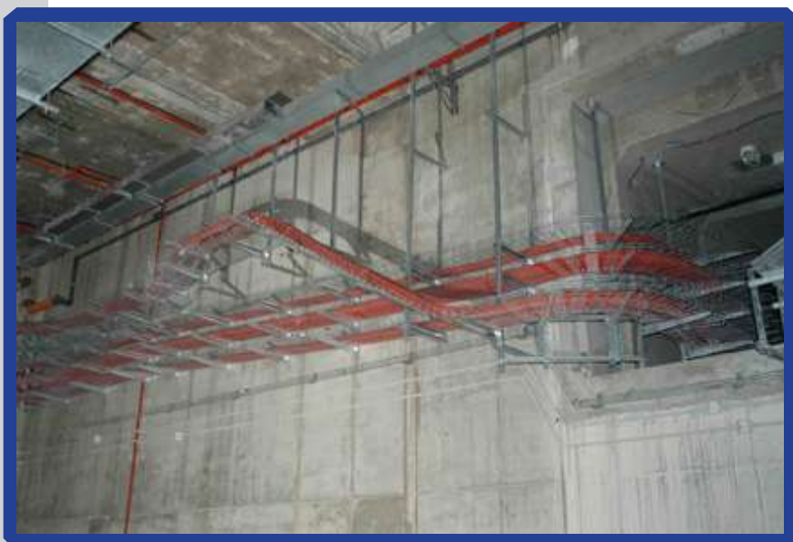
Instalación de bandeja Rejiband con estructuras metálicas.
