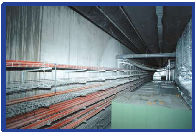
Rejiband en Galería de Servicios.
