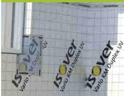
Detalle del sellado de juntas en esquinas y rincones. VARIO KM Duplex UV tiene líneas punteadas para facilitar su plegado y adaptarlo a cualquier esquina. Las juntas estancas con VARIO KM Duplex UV se crean uniéndolas con VARIO KB1.
