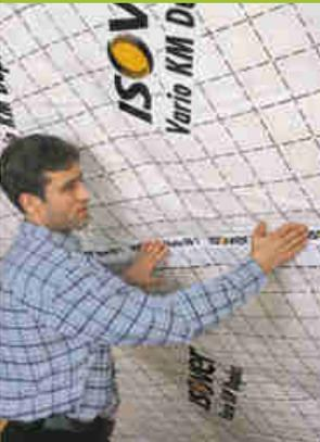
Las uniones de la membrana se solapan en aprox. 10 cm y se sellan con cinta adhesiva VARIO KB1.
