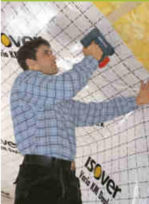
La membrana climática VARIO KM Duplex UV se instala en la subconstrucción tras el aislamiento. En las construcciones de metal, la membrana climatizadora se pega.
