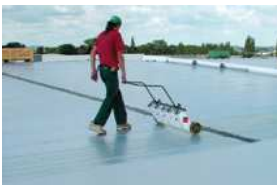
Fig 1: Aplicación del adhesivo 81068 con carro
