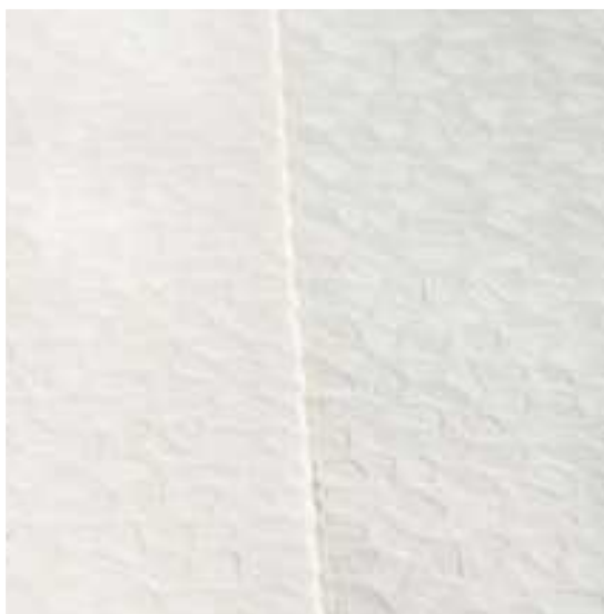
En el caso de la instalación de RENOLIT ALKORBRIGHT, las soldaduras casi no se ven.
