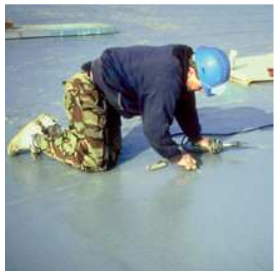
Fig.2: Control de las soldaduras
