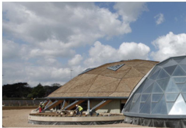
Centro de Deporte y Recreación – Reino Unido Perfiles RENOLIT ALKORSOLAR como base para el montaje de tejas de cedro y paneles de aluminio.
