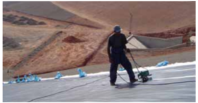
Doble soldadura con aire caliente
