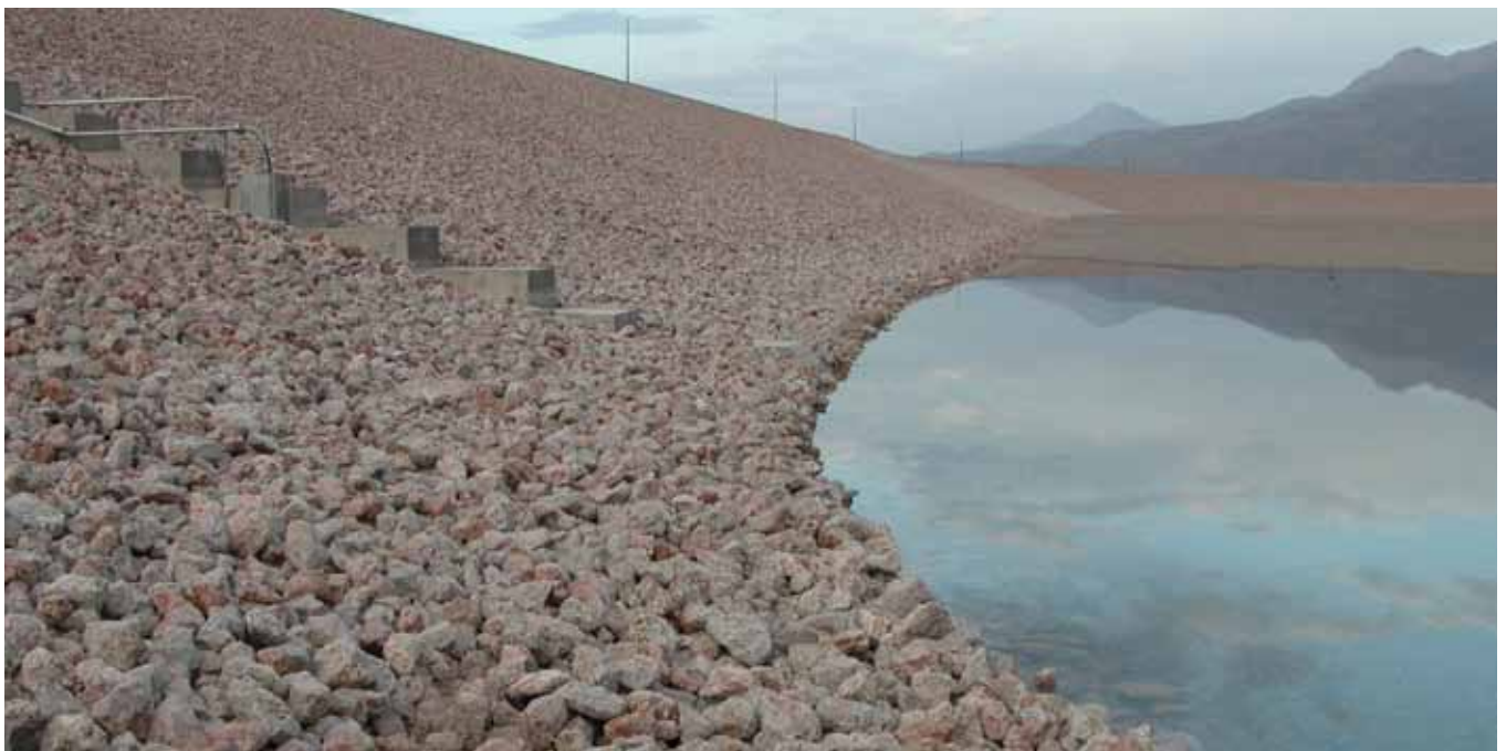
Sistema de impermeabilización con grava como protección
