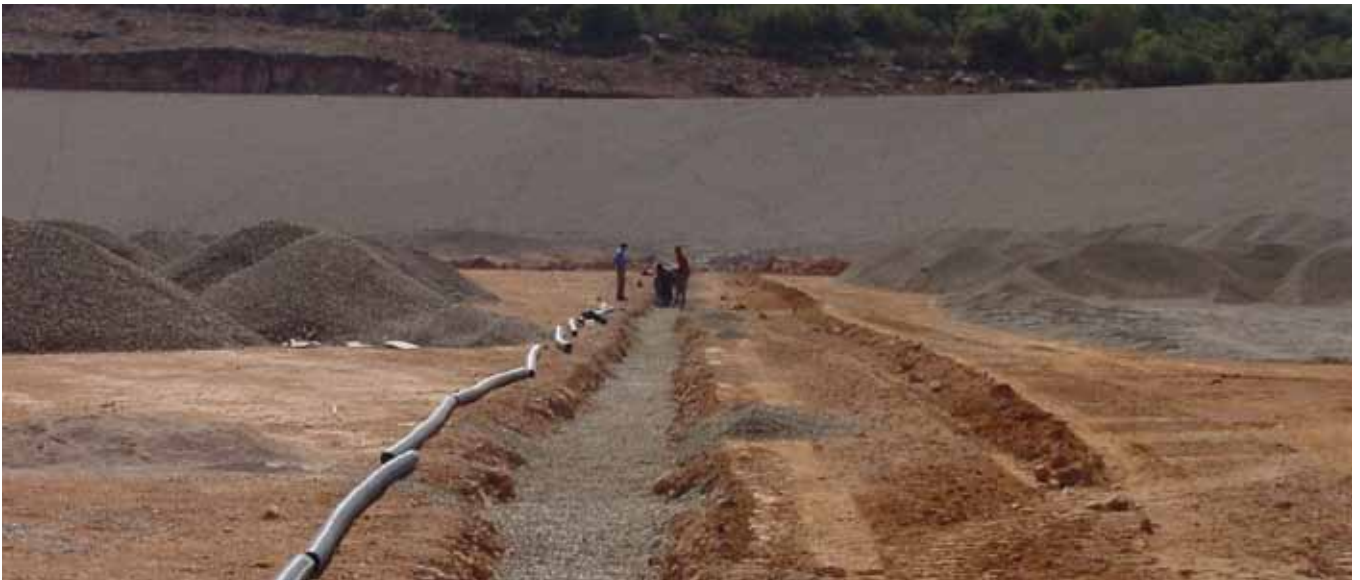
Canalización de drenaje debajo del sistema de impermeabilización
