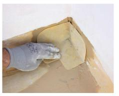
8. Utilizar los diferentes complementos DRY80 CORNERIN, CONEROUT y SUMI56 para resolver los puntos singulares.
