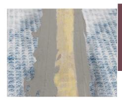
6. Sellar la banda con otra pasada de adhesivo impermeable y elástico en base cementosa (doble sellado).
