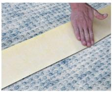
5. Realizar las uniones entre láminas con DRY50 BANDA 13 y adhesivo impermeable y elástico en base cementosa.
