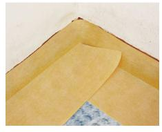
7. Realizar las uniones con los paramentos verticales con **DRY80 BANDA** solapando con un mínimo de 10 cm sobre la lámina DITEC 3.
