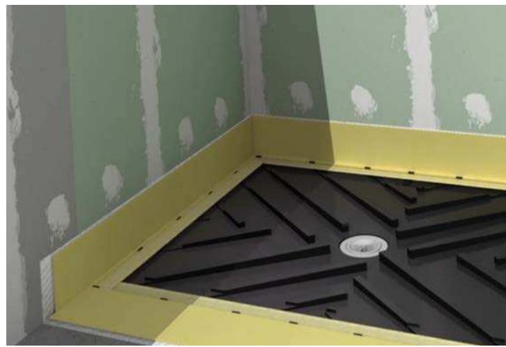
**2\_8** Para evitar manchar el plato, colocar cinta carrocería gruesa en todo el perímetro, desde los topes del plato hacia el interior. Pegar la banda **DRY50 BANDA** sobre los cuatro áleros del plato con adhesivo **REVESTECHflex**. Pegar la banda **DRY50 BANDA** a los encuentros con suelos y paredes, usando cemento cola clase C2.
