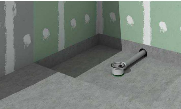
**2\_1**\_Conectar el sumidero. La tubería deberá tener una pendiente  $\geq 2\%$ . Comprobar la correcta evacuación.
