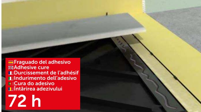
**4\_2** Colocar los perfiles cortados sobre el plato, en la misma posición. Pegar la piezas cerámicas sobre los perfiles con adhesivo REVESTECHflex.
