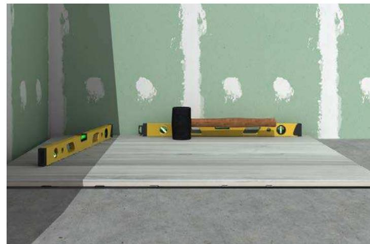
**2\_4**\_Es fundamental que el plato **level** quede totalmente plano. Las piezas de cerámica que van colocadas sobre él deben estar totalmente apoyadas y estables sobre los nervios del propio plato **level**. Para ello debemos de realizar los siguientes ajustes y comprobaciones: una vez la capa de mortero esté fraguada. Comenzar a nivelar siempre con la cerámica preinstalada encima, hasta que quede totalmente asentado el plato.
