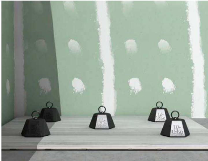
**2\_5** Colocamos peso encima del plato **level** repartiendo bien las cargas. Muy importante poner el peso siempre sobre la cerámica colocada, nunca directamente encima del plato. Volvemos a comprobar que este todo a nivel (FOTO 2). Esperamos a que esté el cemento cola totalmente fraguado para retirar el peso.
