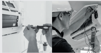
Difícil conexión eléctrica
